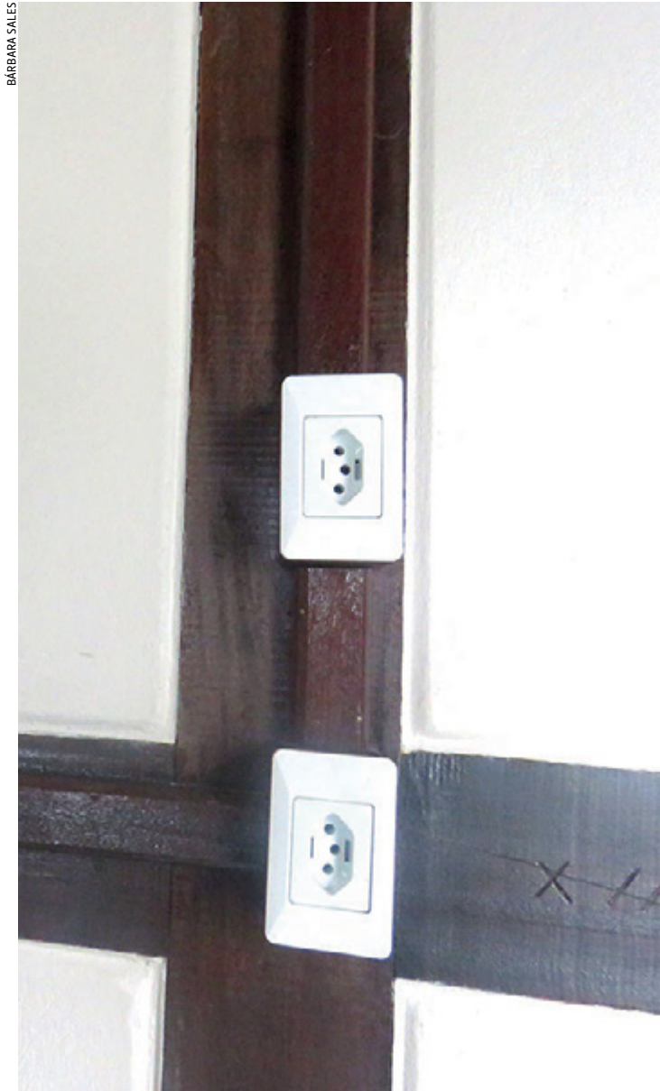
Um dos principais desafios foi a fiação elétrica, que teve de ser passada por fora da parede
