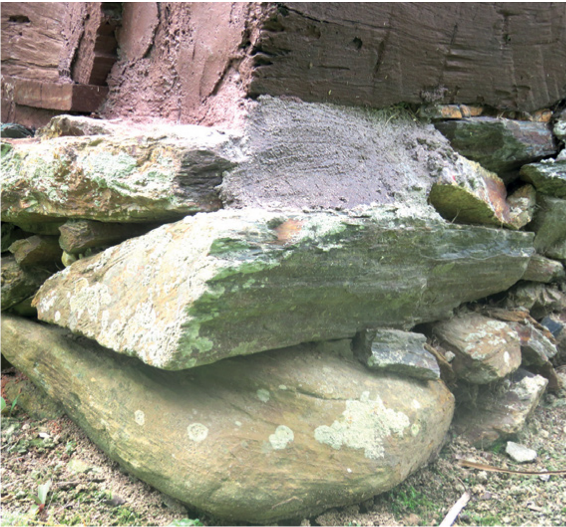
casa foi construída em cima de blocos de pedra
