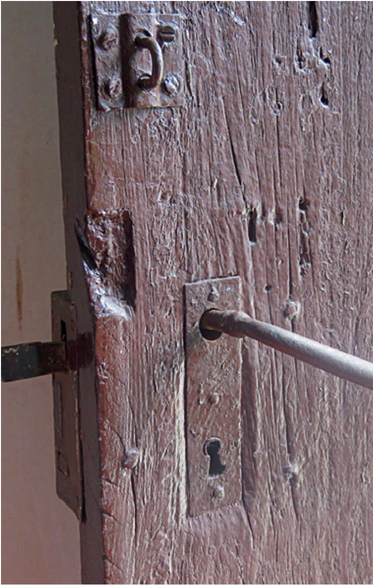
Uma das portas da casa é a mesma da época em que foi construída
